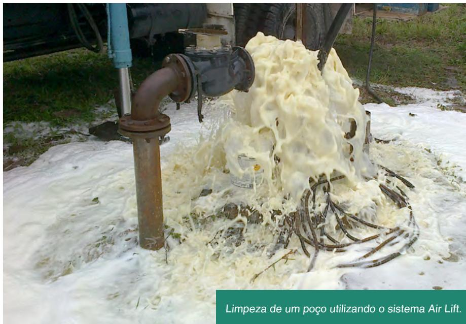
Limpeza de um poço utilizando o sistema Air Lift.
