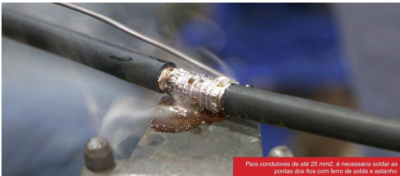
Para condutores de até 25 mm<sup>2</sup>, é necessário soldar as pontas dos fios com ferro de solda e estanho.
