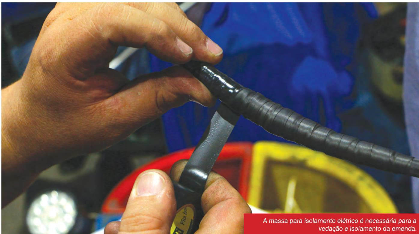
A massa para isolamento elétrico é necessária para a vedação e isolamento da emenda.
