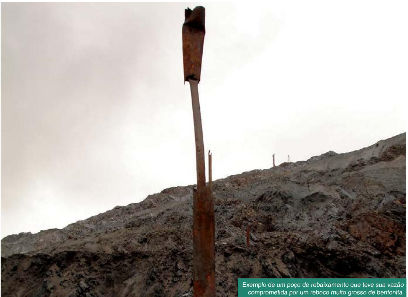
Exemplo de um poço de rebaixamento que teve sua vazão comprometida por um reboco muito grosso de bentonita.
