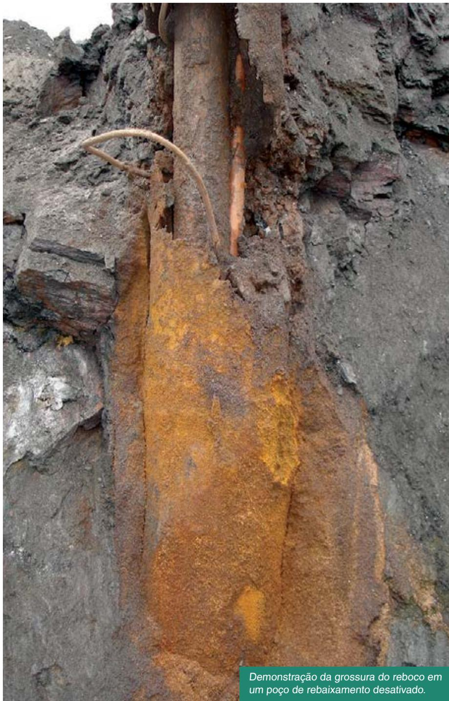
Demonstração da grossura do reboco em um poço de rebaixamento desativado.
